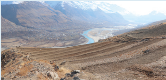
Terrasses construites pour stabiliser les pentes et limiter l'érosion des sols
